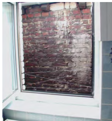
Bild 2 Blick aus dem Badezimmer auf die Nachbarfassade
